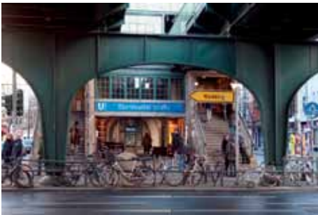
U-Bahnhof Eberswalder Straße
